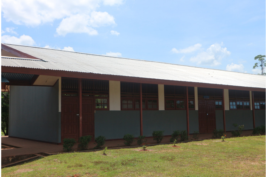
Ruang-ruang kelas di SMAN 1 Muting, Merauke.
